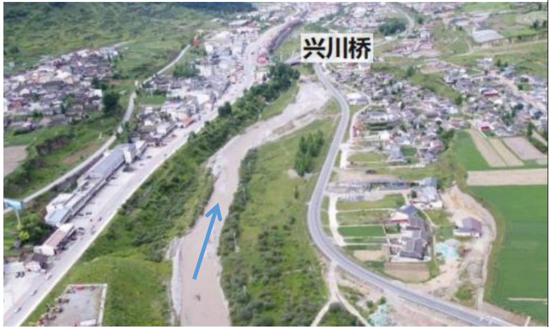
图 3-6 松潘县水生态综合治理工程（一期）下游现状图
