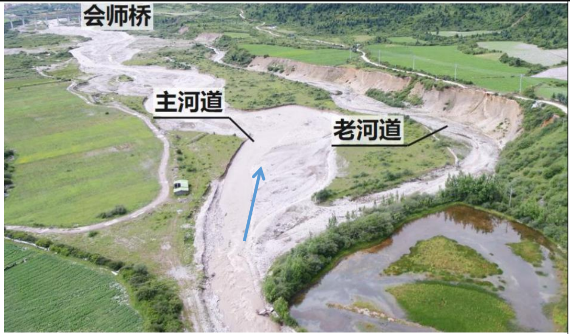
图 3-4 松潘县水生态综合治理工程（一期）上游现状图
